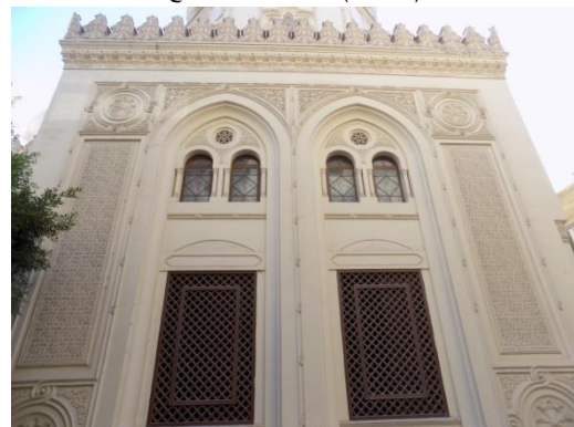
(لوحة ٢١) الواجهة الشمالية الشرقية للضريح
