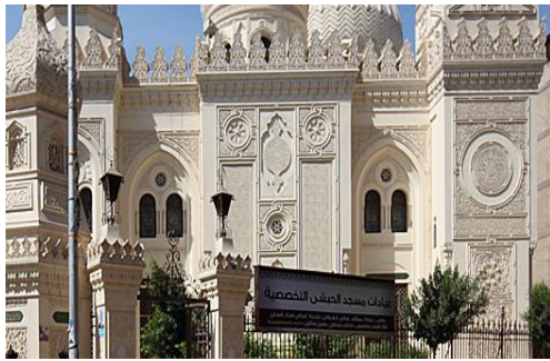
(لوحة ١٢) الواجهة الجنوبية الشرقية للمسجد
