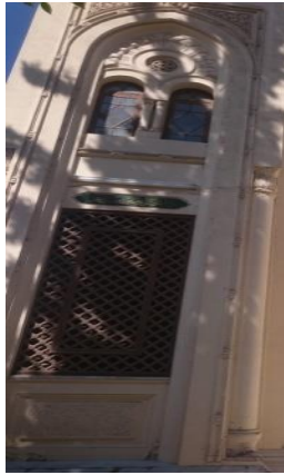
(لوحة ١٨) القسم الخامس من الواجهة الجنوبية الشرقية
